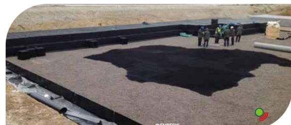
Befüllung der Behandlungsstufe einer Rigole für die Abläufe eines Asphaltwerkes mit ENREGIS/Vivo Bioalith<sup>®</sup> MR-F1 (DK)
