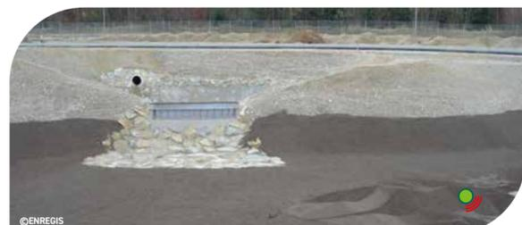
Muldenystem mit ENREGIS/Vivo TRP<sup>®</sup> zur mechanischen Vorreinigung und mit ENREGIS/Vivo Bioalith<sup>®</sup> zur Biofiltration (DE)
