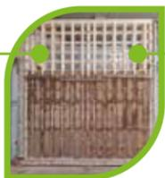
Füllung mit Inlets & Zwischenplatten aus Lehm
