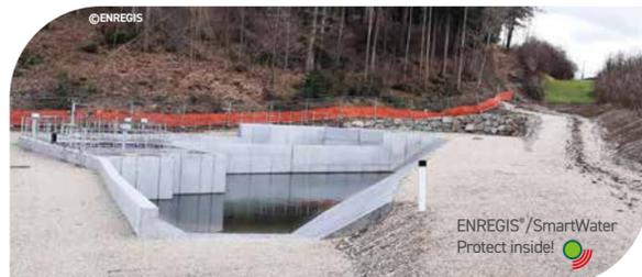
ENREGIS/Vivo Bioalith<sup>®</sup> MR-F2 in einer Behandlungsanlage für die Regenwasserabläufe eines Autobahnschnittes (AT)
