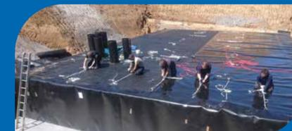
Aufbau einer Rückhaltung in der Baugrube im Zeitraffer:
