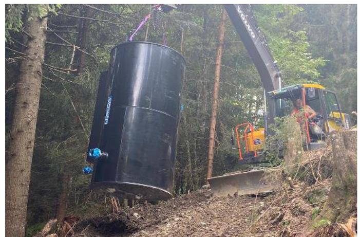
*Vertikale Verlegung mit einem Bagger*
