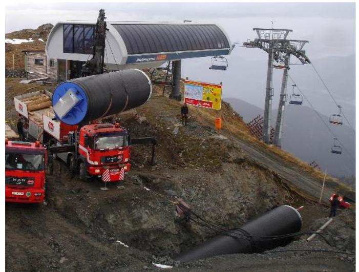
*Horizontale Verlegung mit einem LKW-Kran*
