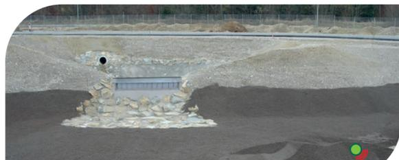
Muldenystem mit ENREGIS/Vivo TRP® zur mechanischen Vorreinigung und mit ENREGIS/Vivo Bioalith® zur Biofiltration (DE)
