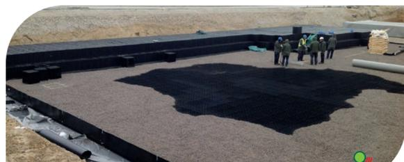
Befüllung der Behandlungsstufe einer Rigole für die Abläufe eines Asphaltwerkes mit ENREGIS/Vivo Bioalith® MR-F1 (DK)
