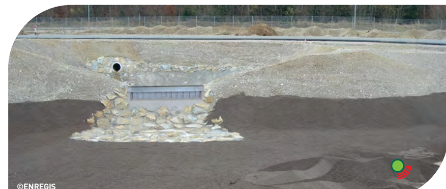
Muldensystem mit ENREGIS/Vivo TRP® zur mechanischen Vorreinigung und mit ENREGIS/Vivo Biocalith® zur Biofiltration (DE)
